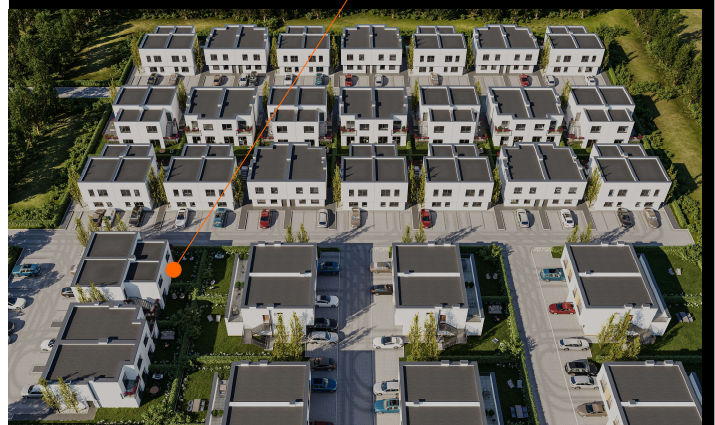
BUDYNEK 36C. lokal I
