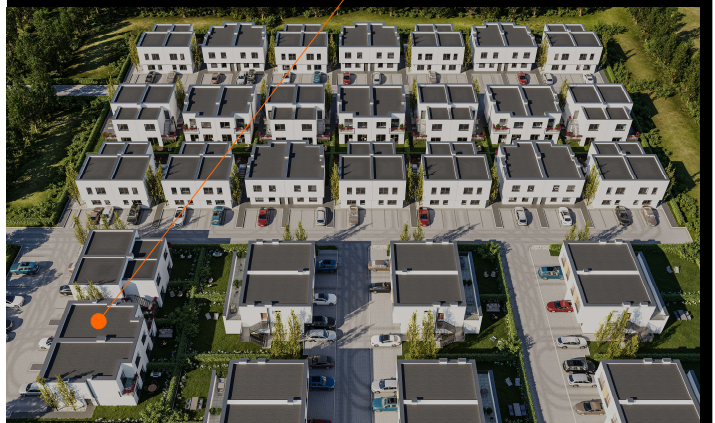
BUDYNEK 36A. lokal II
